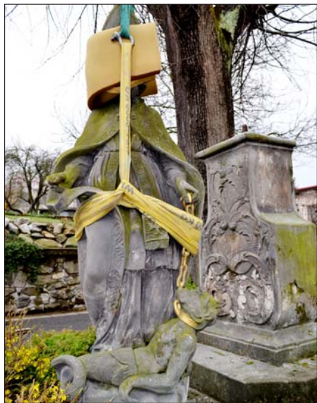
Z demontáže sochy.
